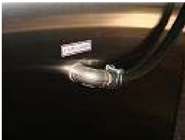
Se recomienda utilizar selladores de siliconas en las uniones, para evitar fugas. Especialmente si esta cañería es muy larga, y dentro del recinto de esterilización ya que cerca del equipo, durante la ventilación, en la cañería hay una ligera presión contra el ambiente.
