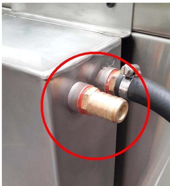
Se recomienda utilizar selladores de siliconas en las uniones, para evitar fugas. Especialmente si esta cañería es muy larga, y dentro del recinto de esterilización ya que cerca del equipo, durante la ventilación, en la cañería hay una ligera presión contra el ambiente.
